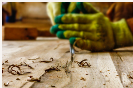
Ausarbeitung der Risse in Handarbeit mit Stechbeitel
