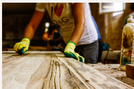
Schleifen eines zuvor ausgearbeiteten Risses
