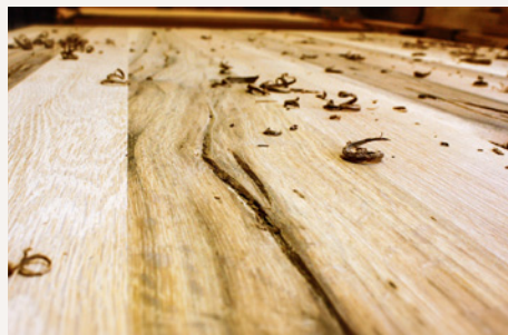
Grob ausgearbeitete Risse
