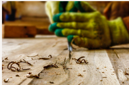
Ausarbeitung der Risse in Handarbeit mit Stechbeitel
