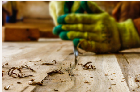
Ausarbeitung der Risse in Handarbeit mit Stechbeitel
