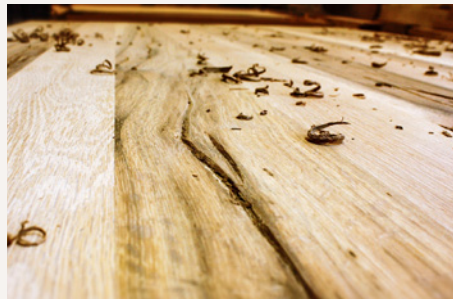
Grob ausgearbeitete Risse
