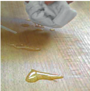
Wasser an schadhafte Stelle einwirken lassen
