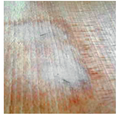
ausgeschliffene Stelle
