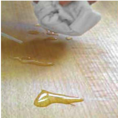
Wasser an schadhafter Stelle einwirken lassen
